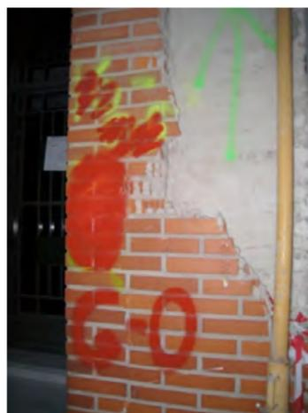
Figura 2 – Marcações sobrepostas utilizadas na classificação de um edifício
